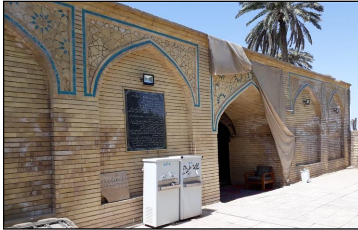
(الصورة - ٧) الواجهة الداخلية المظلة على الصحن
